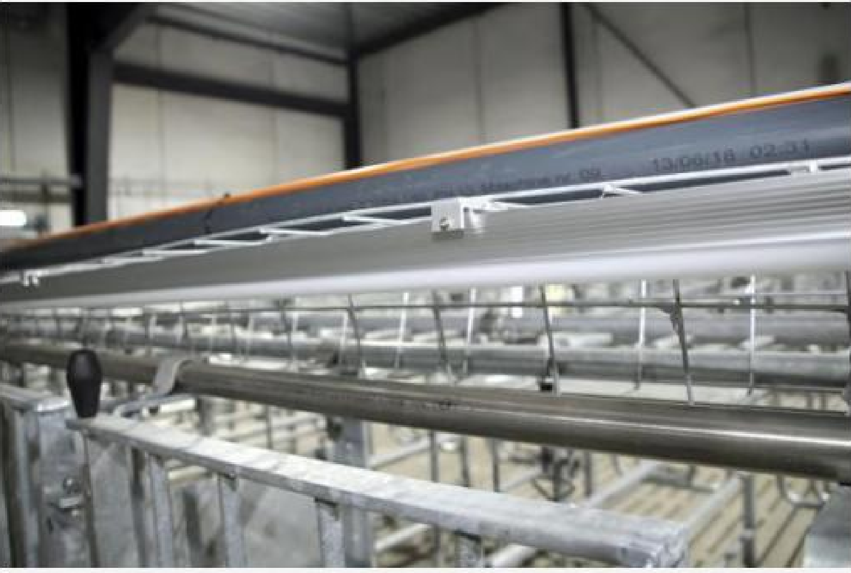
Für die Scheune wurde in LED-Beleuchtung investiert. Teilweise im Løet, es wurden aber auch Lichter vor allen installiert Koppeln für eine bessere Fortpflanzung.
